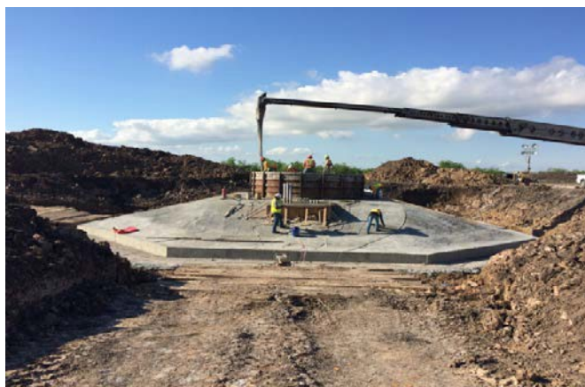
La colocación del concreto para el pedestal de cimentación de la turbina
